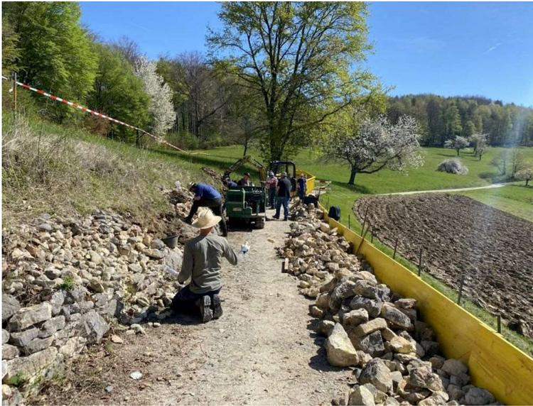
Beginn der Abbrucharbeiten der ersten Mauerhälfte am Montag, 25. April 2022. Die Steine wurden von Hand abgebaut und zur weiteren Verwendung beiseitegelegt. Enthaltene Bollensteine wurden separat gesammelt und abtransportiert. Der manuelle Abbau ermöglichte es einzelnen Lebewesen, in den vorderen Teil der Mauer zu flüchten. Wir fanden einzelne Exemplare der Zauneidechse, Blindschleichen, Frösche, Feuersalamander und Bergmolche.
