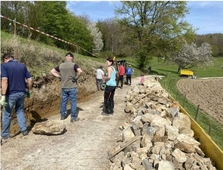
Mit dem Bagger wurde das Fundament leicht abgezogen und das Fundament wiederhergestellt. Der Wiederaufbau konnte beginnen.
