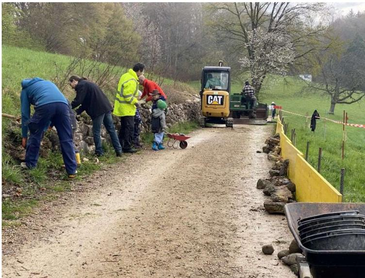
Start der Abbrucharbeiten der **zweiten Hälfte** der Mauer am Montag, 12. April 2023. Die Steine wurden wieder von Hand entfernt und zur weiteren Verwendung zur Seite gelegt.
