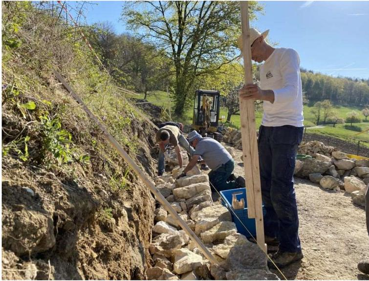
Richtschnüre und Holzlatten wurden gesetzt und ausgerichtet. Das Fundament konnte mit den vorhandenen grossen, schweren Steinen errichtet werden. Der Wiederaufbau Stein für Stein nahm viel Zeit in Anspruch. Jeder Stein wurde beschlagen und eingepasst.
