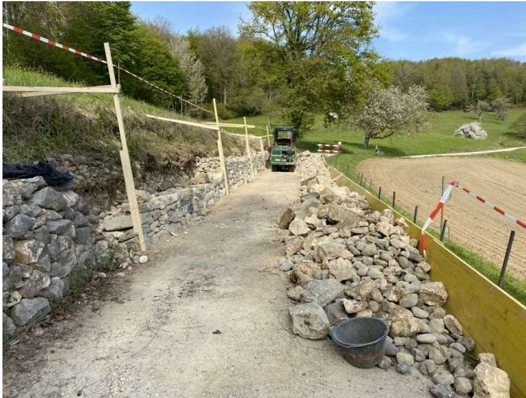
Im Bildausschnitt links ist der alte Teil der Mauer zu sehen. Der neue Teil ist bereits ziemlich hoch aber noch nicht fertig gebaut.
